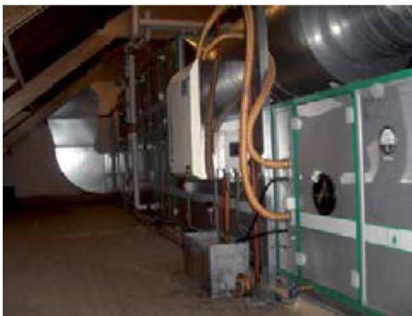
Рис. 3.22. Приклад обладнання для штучної вентиляції
