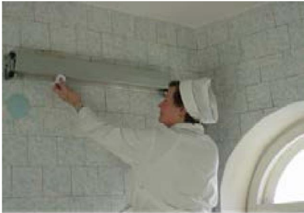
Рис. 3.6. Очищення БУФ світильника у медичному закладі
