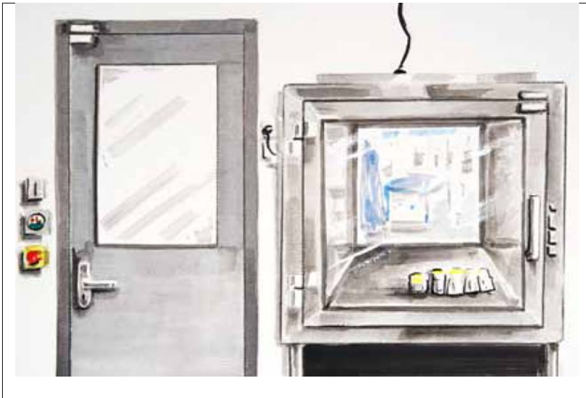
Прохідний бокс - це санітарний шлюз для дрібних предметів
